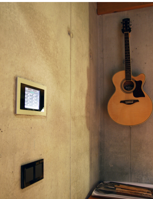
Pomoću GIRA info-touch zaslona korisnik na jednostavan način upravlja cijelom kućom i okućnicom, sve do ventilatora na kaminu ili prskalica na zelenoj površini
